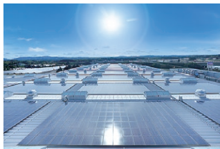
レンゴー(株)福島矢吹工場
