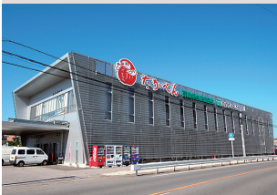
高崎弁当(株) 本社工場
