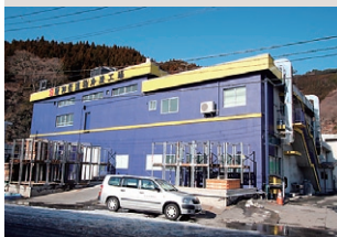
阪神低温(株) 釜石冷凍工場
