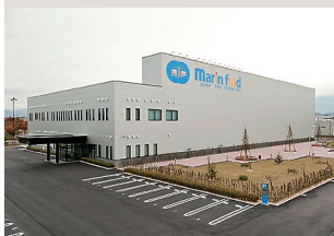
マリンフード(株) 長浜工場
