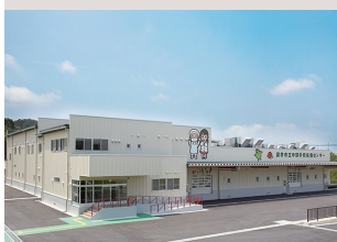
袋井市立中部学校給食センター
