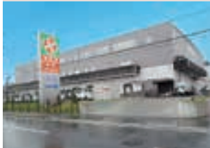
(株)ライフコーポレーション 船橋プロセスセンター
