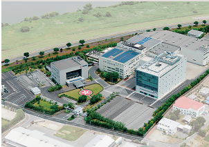
日本食研ホールディングス(株) 千葉本社 (千葉工場)
