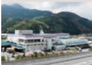
四国乳業(株) 本社工場
