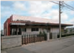
野々市市小学校給食センター
