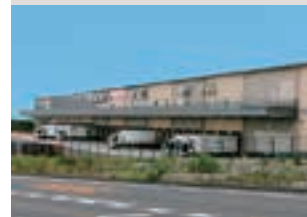
マックスバリュ東海(株) イオン長泉ロジスティクスセンター水産加工室
