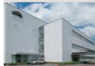
(株)榮太樓總本舗 八王子工場
