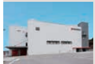
高砂香料西日本工場(株) 三原工場
