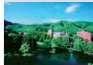
ニッカウキスキー(株) 仙台工場・宮城峡蒸溜所
