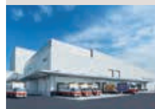
山崎製パン(株) 神戸工場
