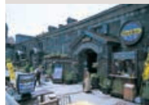
(株)アレフ 小樽ビール醸造所・小樽倉庫 No.1
