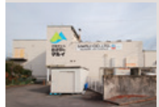
(株)マル井 本社工場
