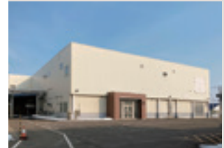
よつ葉乳業(株) 十勝主管工場 チーズ工場
