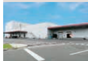
カルビー(株) 京都工場 フルグラ生産棟
