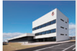
(株)陣中 新本社工場
