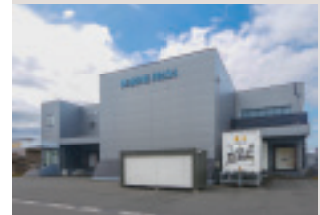
(株)マリフレッシュ 関西工場
